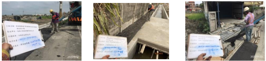
圖7. 使用低強度回填材料回填水溝路側開挖面
