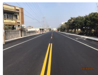
圖11. 瀝青混凝土路面鋪設後。
